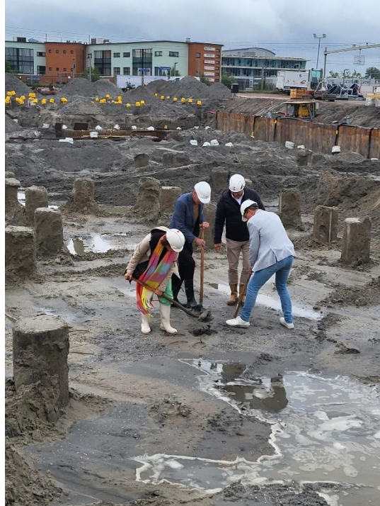
Start Bouw Stationsmeester, Dijk en Waard
