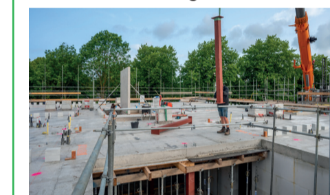
Voortgang bouw appartementen
